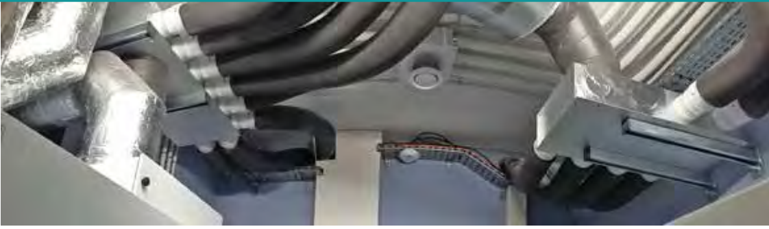
Vue panoramique des caissons répartiteurs de la VMC double flux.
