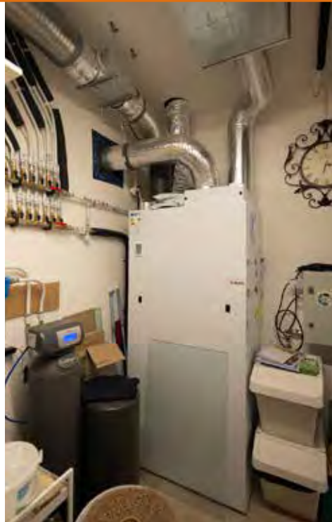
La Compact C de Nilan: un seul appareil pour le chauffage, la ventilation, le froid et l'ECS. Un gain de place et de belles performances.
