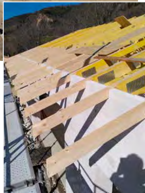
Détails de la charpente et des débords de toiture.
