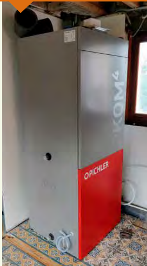
La VMC Double Flux Thermodynamique 4 en 1 PKOM ® distribuée par GECO. Un appareil compact assurant la ventilation, le chauffage sur l'air, l'eau chaude sanitaire et le rafraîchissement. Détentrice d'un TITRE V RE2020.
