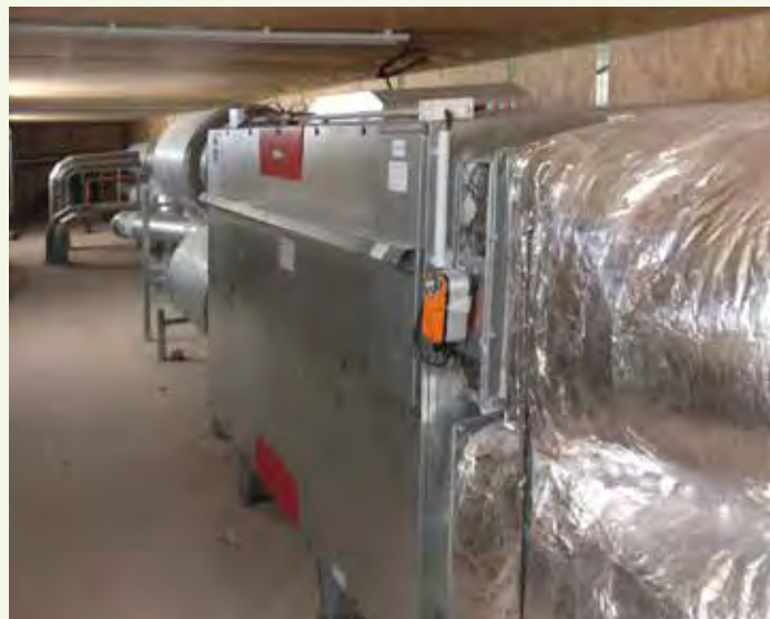
Accès facile pour le changement des filtres. VMC ComfoAir350 de Zehnder
