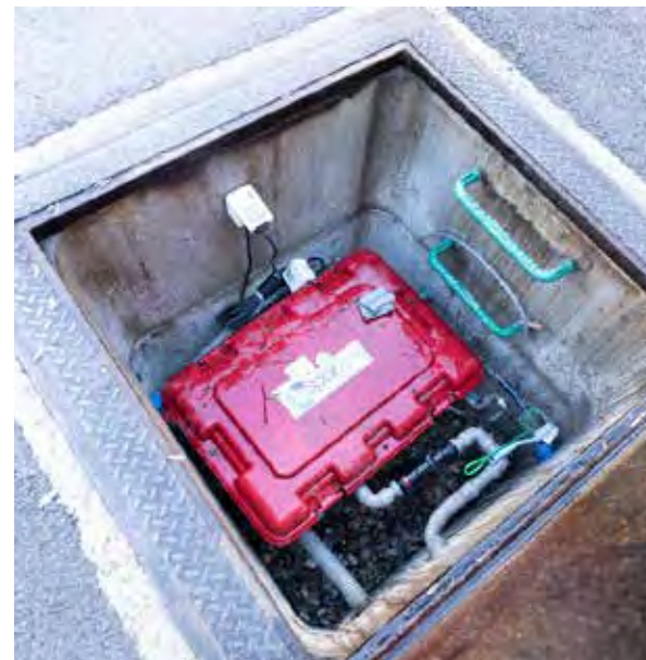
Le Spareau, permet de récupérer les eaux grises pour alimenter les toilettes.
